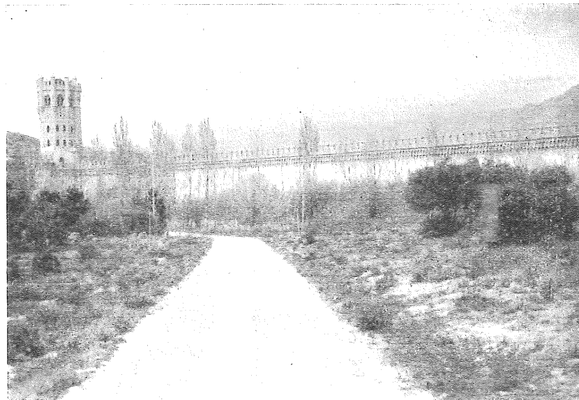
Foto 3.—Presa de Manzanares el Real.
